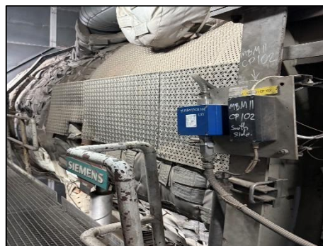
รูปที่ 2-16 ระบบฉนวนป้องกันความร้อน หรือฉากป้องกันความร้อน
