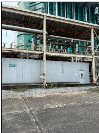
รูปที่ 2-4 การติดตั้งอุปกรณ์ลดเสียงดังจากเครื่องจักร
