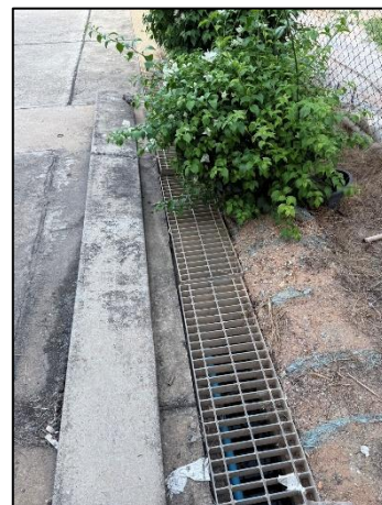
รูปที่ 2-9 รางระบายน้ำฝนโดยแยกน้ำฝนปนเปื้อนและน้ำฝนไม่ปนเปื้อนออกจากกัน
