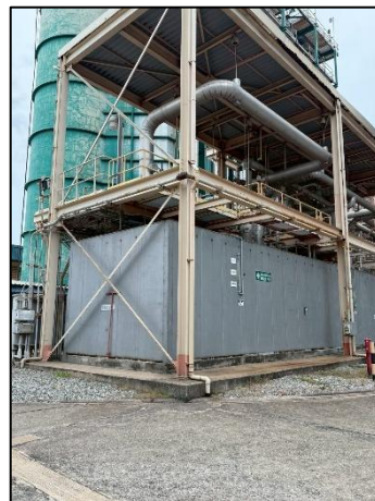
รูปที่ 2-4 การติดตั้งอุปกรณ์ลดเสียงดังจากเครื่องจักร
