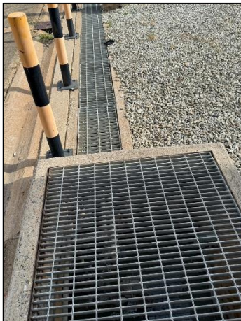
รูปที่ 2-9 รางระบายน้ำฝนโดยแยกน้ำฝนปนเปื้อนและน้ำฝนไม่ปนเปื้อนออกจากกัน
