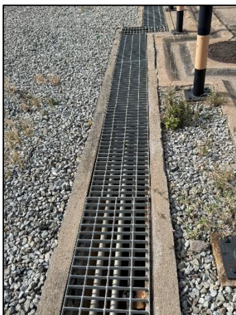
รูปที่ 2-9 รางระบายน้ำฝนโดยแยกน้ำฝนปนเปื้อนและน้ำฝนไม่ปนเปื้อนออกจากกัน
