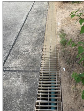
รูปที่ 2-9 รางระบายน้ำฝนโดยแยกน้ำฝนปนเปื้อนและน้ำฝนไม่ปนเปื้อนออกจากกัน
